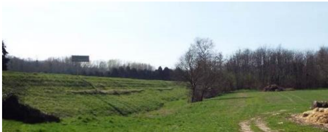
Route surélevée rive gauche (Chargé)
