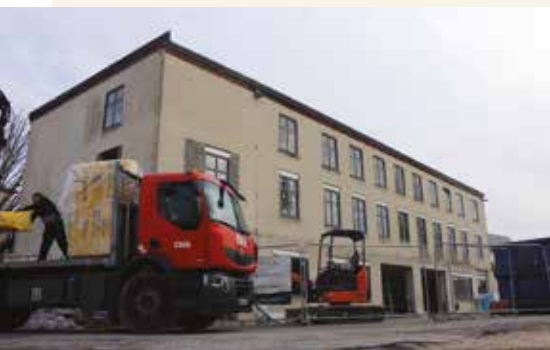
↳ L'auberge de l'Île d'Or en chantier.
