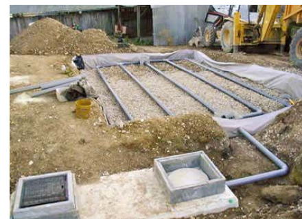
Une installation d'assainissement autonome en cours de réalisation
