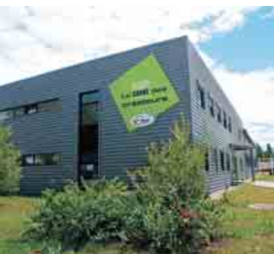
Le Carré des Créateurs, à Bourges, est géré par l'Agence de développement du Cher. La pépinière, dans 1 800 m 2 de locaux, propose 17 bureaux, 9 ateliers, des salles de réunion et des services communs (standard, photocopie, documentation...)
