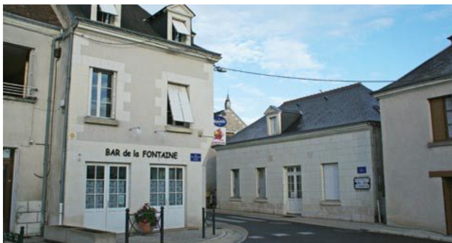
Le local commercial et le gîte ont été réalisés par Val d'Amboise en 2005
