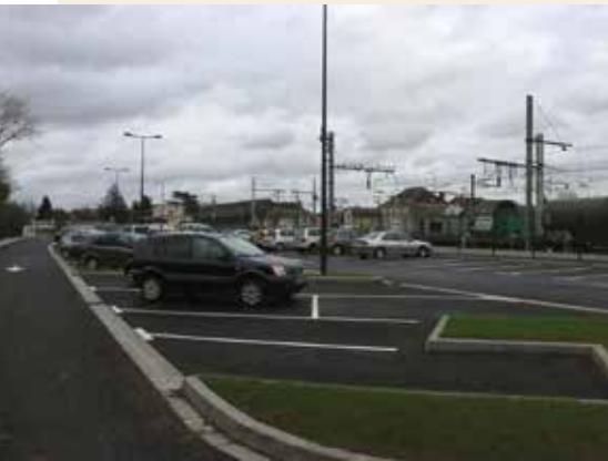
↗ L'extension du parking de la gare SNCF
