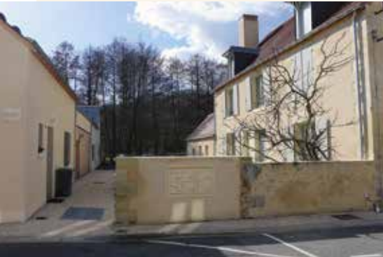
📍 Nouveaux logements à Saint-Ouen-les-Vignes.
