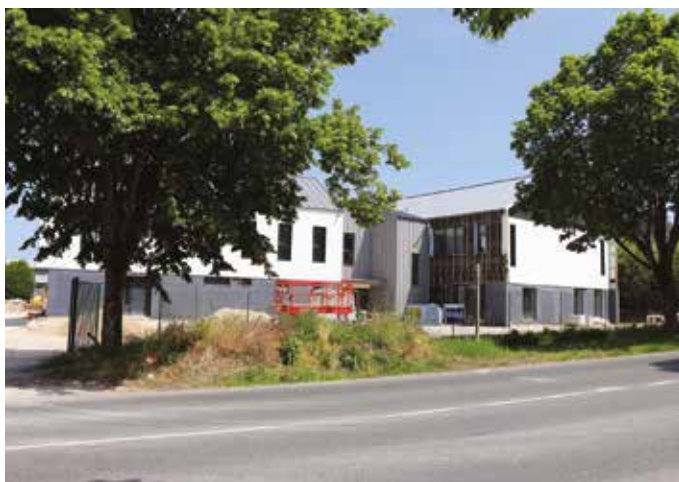
Le chantier de construction le 18 mai 2018.
