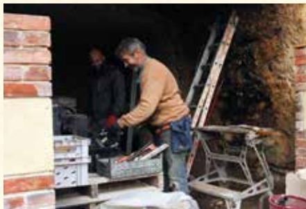
Un chantier accompagné en novembre 2019.
