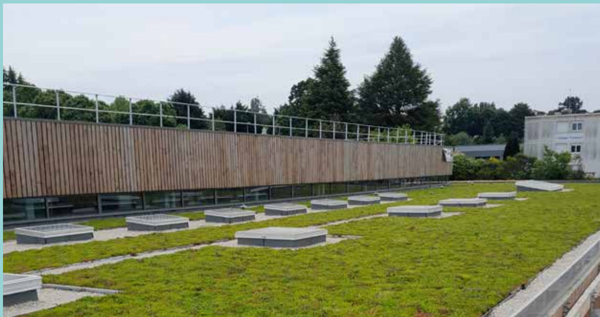
Toiture végétalisée du Centre Aquatique
