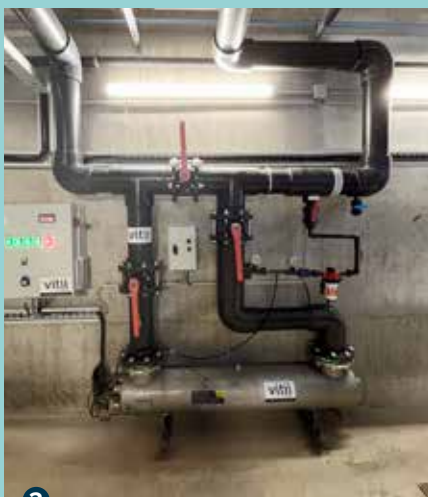
Réacteur UV - L'eau est désinfectée et épurée par un réacteur UV qui lui garantit sa cristallinité.
